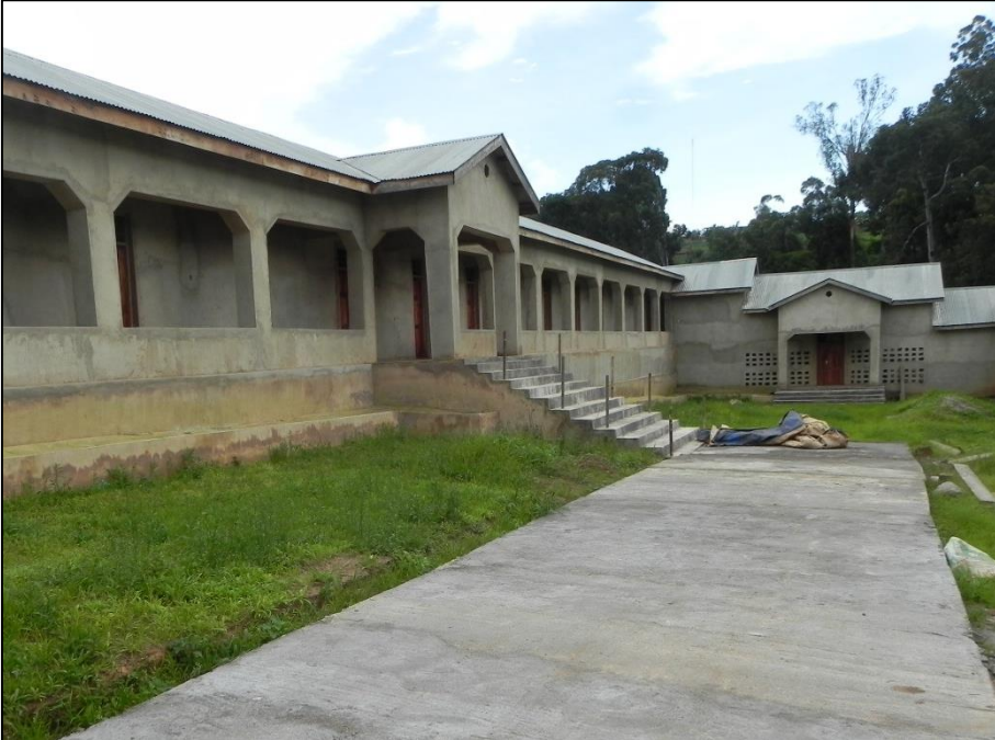
Innenhof mit Blick auf die Sanitäreanlagen
